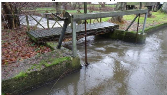
Figur 4.3 Regulerbart overløbsskod, spang forrest i figuren og fisketrappen i baggrunden.
