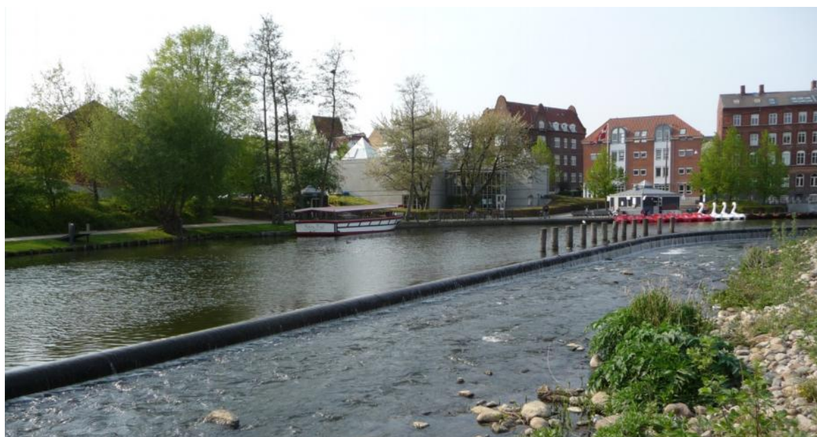
Figur 28 Eksempel på spunsløsning, adskillelse mellem mølledam og omløbsstryg
