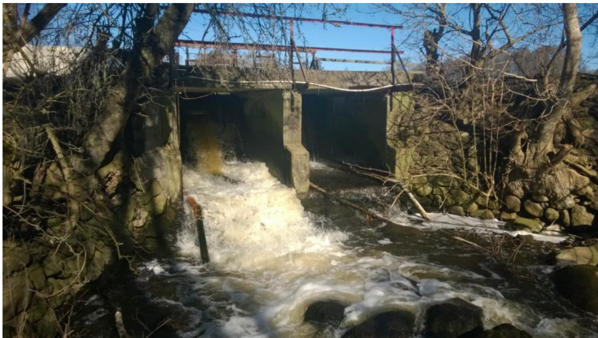
Figur 3 Opstemning og frisluse for Gundestrup Mølle.
